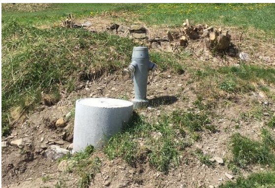
Wasserhydrant zur Wasserverteilung in Inden
